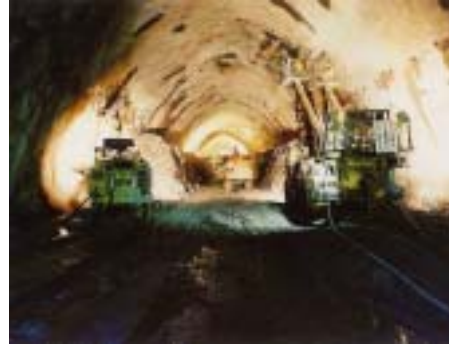
第1段ベンチ掘削
