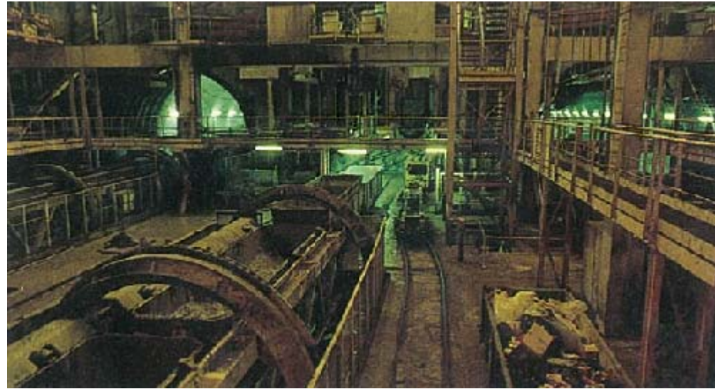
フランスサンガッテ立坑、両側：本トンネル 中央：サービストンネル
