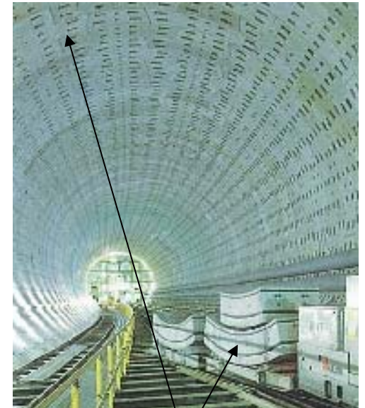
シールドトンネル内
