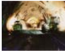
第1段ベンチ掘削
